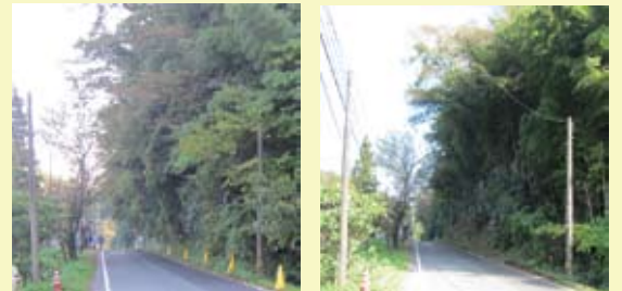
平成26年に実施した道路法面の立木伐採の作業前（左）と作業後（右）。大型バスの進入が容易になりました。
